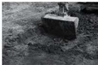
重機による表上の掘削
