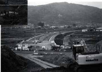
バイパス建設中の風景 (鏡捨停車場線・峯沼取から)
