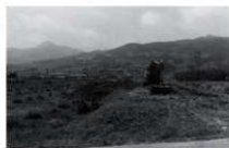
調査前の全景 (A区)
