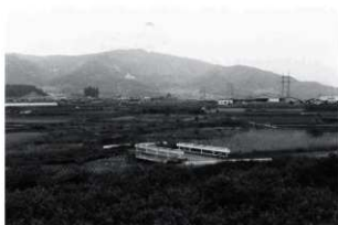
社宮司道跡周辺の調査前全景
