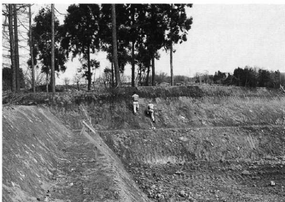
地質調査（工事施工後）
