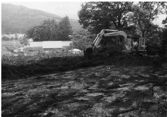
調査地区表土除去
