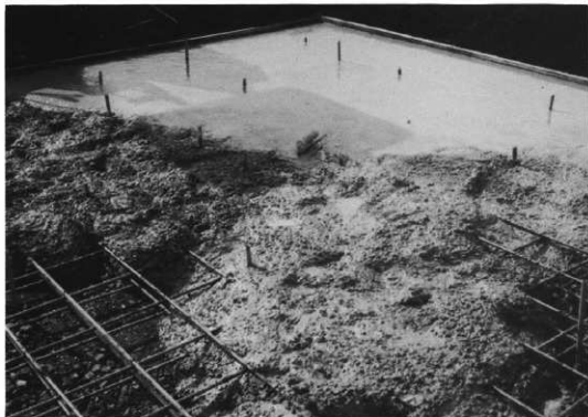
第 62 号復原住居基礎工事
