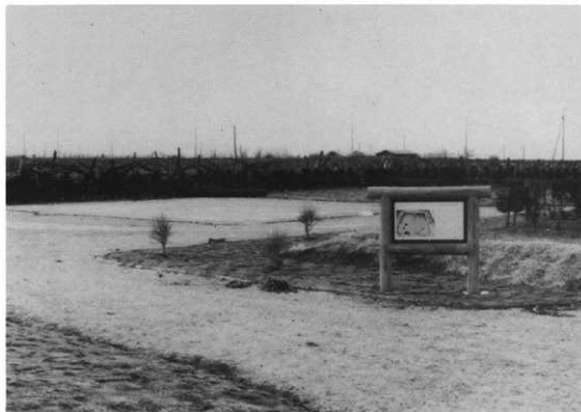
土盛り工事（遊歩道・有明砂舗装）
