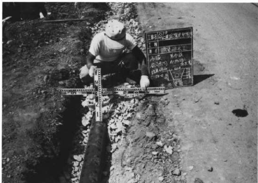
暗渠排水工事
