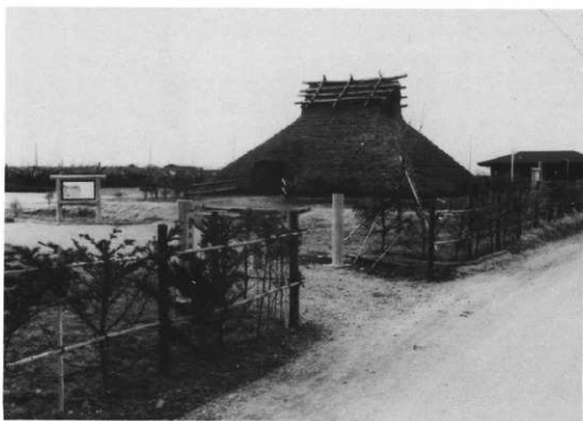
環境整備全景（南側入口より）
