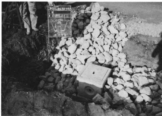
浸透枳設置工事
