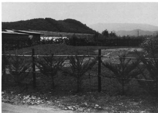
土盛り工事（築山部分）
