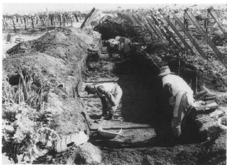
トレンチ掘り下げ (H-126号・127号付近)
