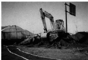
トレンチ検出状況(東より)
