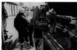
込山E遺跡1遺跡近景(西より)
