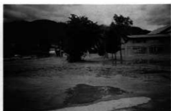
調査前近景図（西より）
