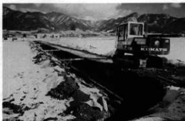
遺跡近景 (西より)
