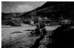
8号トレンチ調査状況(西より)
