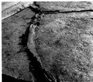
左 @SC4015 右 @SC4015 芯材検出状況
