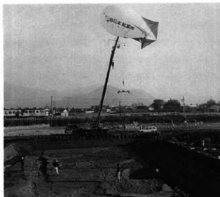
バルーンによる空中写真測量
