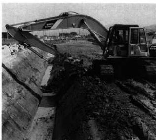
重機による法面の掘削
