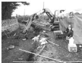
M区調査風景
