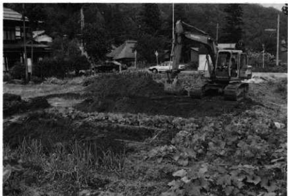
◀ 重機による表土はぎ
