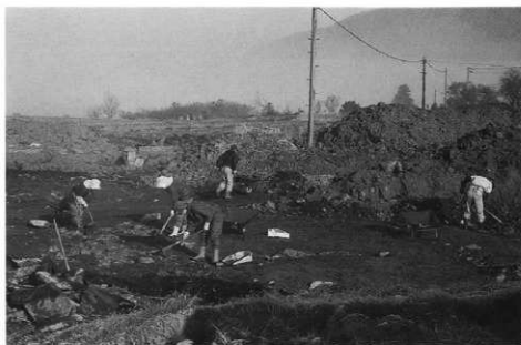
A地区作業風景
