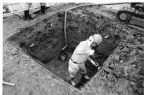
調査風景(南西から)
