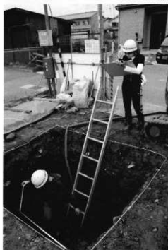
図面作成作業(南西から)
