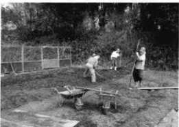
埋め戻しの仕上げ作業
