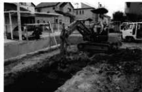
第1調査区埋め戻し作業(北西から)
