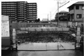
第2調査区埋め戻し後全景(東から)
