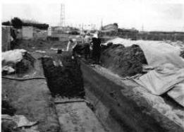
埋め戻し作業
