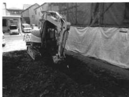
第3調査区掘削風景
