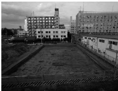
東発掘区全景 (南から)
