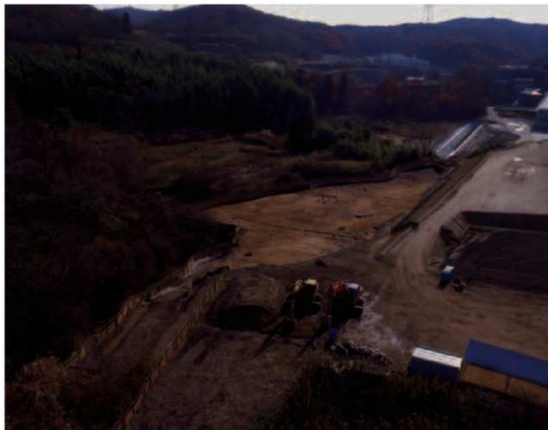
調査区遠景(北より)
