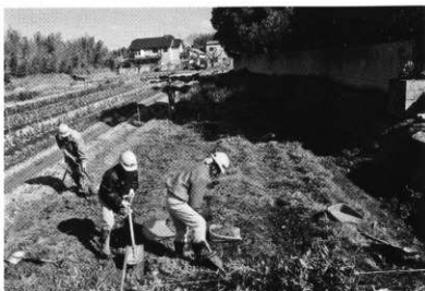
写真2 調査風景（南から）
