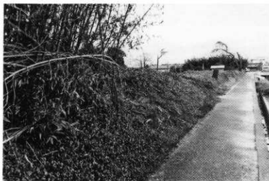
写真14 土塁全景（北から）
