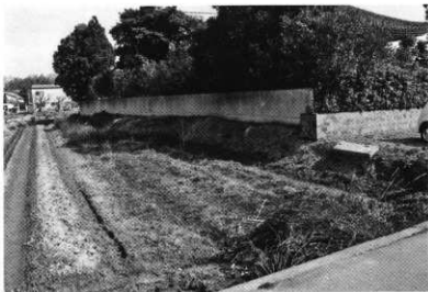
写真1 調査前（南西から）
