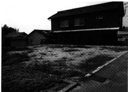
1. 調査前(南東から)
