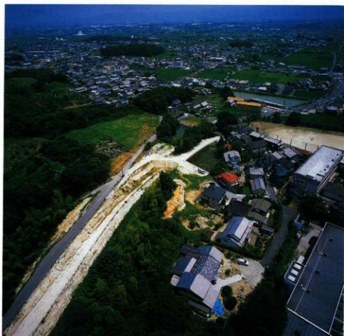
1. 航空写真 (西から)
