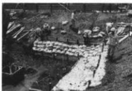
5月は現地において主として準備作業(資機材搬入、本部・作業員用プレハブ設置、工専用道路造成、ガードフェンス仮設など)、表土除去とそれに伴う法面養生などの安全対策、排水溝掘削やポンプ投入などの湧水対策、防塵・防音対策をおこなった。また、地域の自治会長、自治会バイパス対策委員長、田中および池ヶ谷の部農会、静岡市立安東中学校・城北小学校、私立池ヶ谷保育園・北安東保育園・ひまわり学童保育所や、隣接地所有者・居住者に対して発掘調査の説明と協力要請をおこなった。6区においては16日より重機により表土・中間層の除去を開始し、ベルトコンベアーを設置して人力によりC層上面の遺構検出作業を行った。
