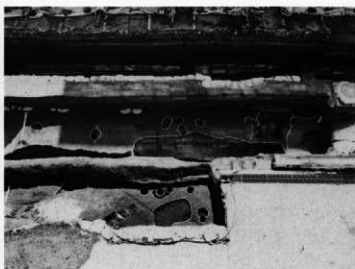
②B区下層東側（北より）
