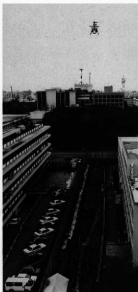
①B区上層全景（東より）
