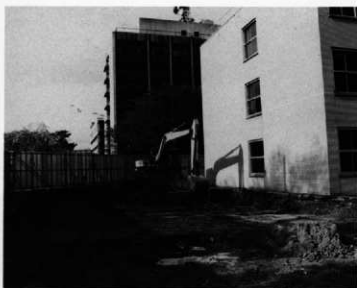
①表土剥ぎ風景
