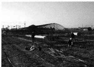
ビニールハウス撤去作業
