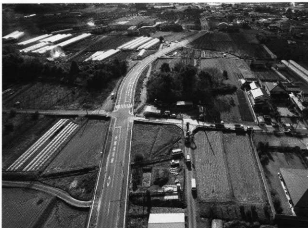
調査地遠景(北から)
