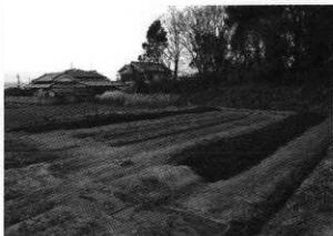
埋め戻し完了
