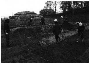
埋め戻し作業
