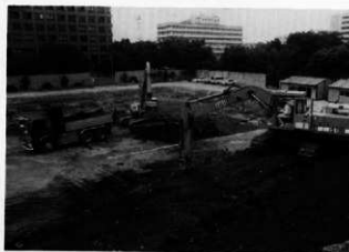
第2図 表土掘削風景
