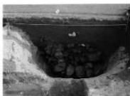
D273 石積セクション (北より)
