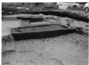
D114 セクション (西より)
