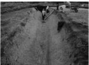
M1 完掘(北より)
