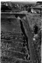
M17 完掘(東より)
