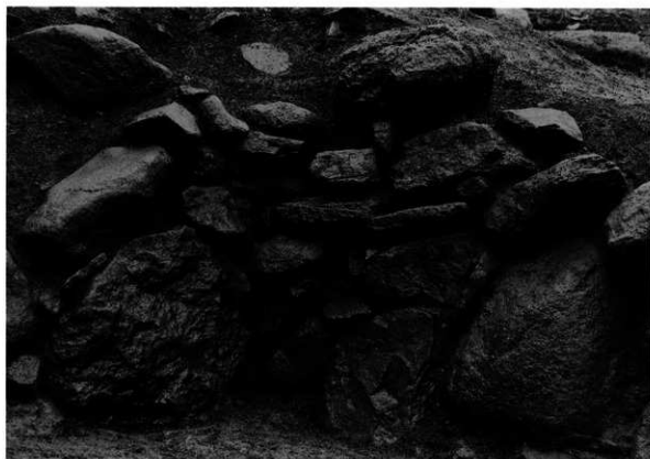
②旧石積み角の状況
