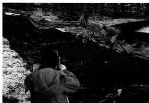
④基準杭測量 平成10年度
