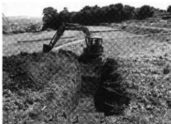
写真2 重機による表土・盛土層の掘削（試掘8-3）
