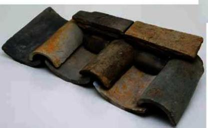
熨斗瓦は長方形板状の瓦で、進物の熨斗包みに似ているところからその名があるといわれる。棟を高く積み上げるために用いる。丸瓦列と平瓦列とが棟に接した部分の隙間を埋める瓦が面戸瓦である。
