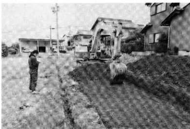
南トレンチ 掘削風景 (南から)
