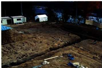
1面遺構完掘状況 (北西から)
