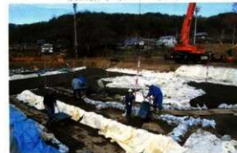
人力と重機による埋戻し作業
