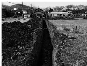
Aトレンチ (東から)
