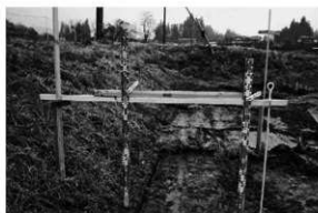
盛土施工確認
