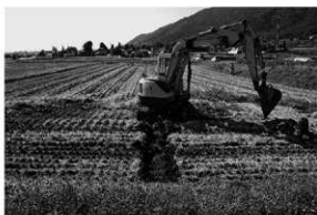
調査状況（北から）
