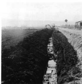
試掘トレンチ
