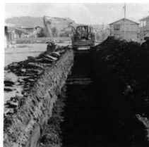
試掘トレンチ
