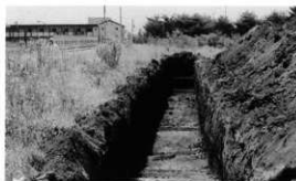
試掘トレンチ
