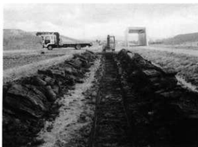
試掘トレンチ
