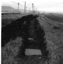
試掘トレンチ
