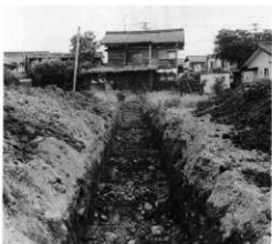
試掘トレンチ
