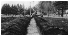
試掘トレンチ
