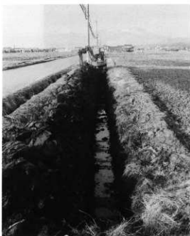
試掘トレンチ
