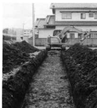
試掘トレンチ
