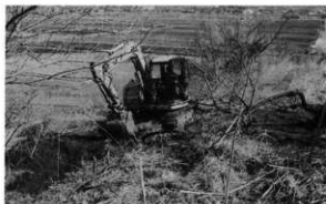
試掘トレンチ
