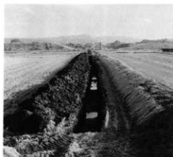
試掘トレンチ
