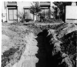
試掘トレンチ
