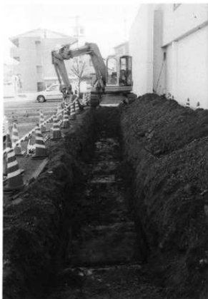
試掘トレンチ
