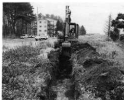
試掘トレンチ
