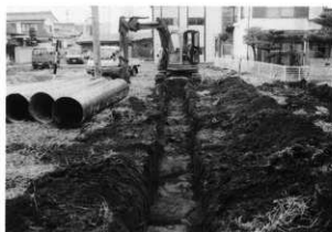
試掘トレンチ
