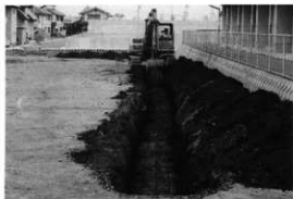
試掘トレンチ
