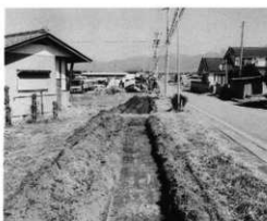
試掘トレンチ
