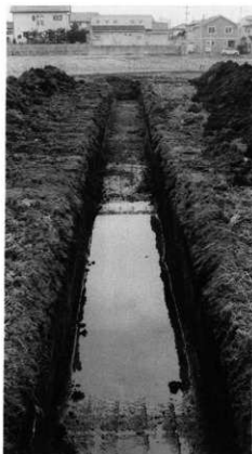
試掘トレンチ
