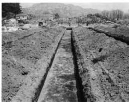
試掘トレンチ
