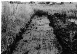
試掘トレンチ
