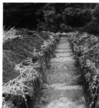
試掘トレンチ
