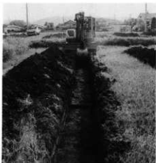
試掘トレンチ
