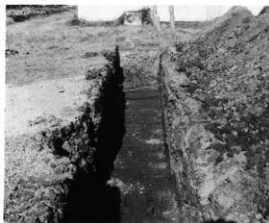
試掘トレンチ
