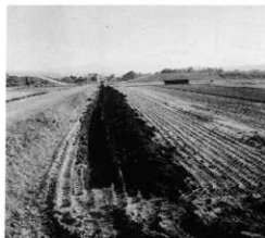
試掘トレンチ
