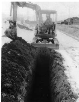
試掘トレンチ
