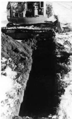
試掘トレンチ
