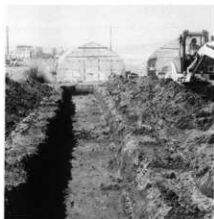
試掘トレンチ
