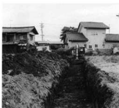
試掘トレンチ
