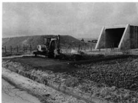
試掘トレンチ
