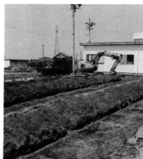
試掘トレンチ
