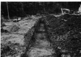
試掘トレンチ
