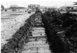
試掘トレンチ
