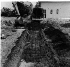
試掘トレンチ
