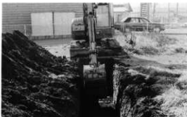
試掘トレンチ
