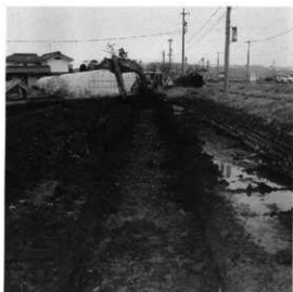
試掘トレンチ
