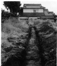
試掘トレンチ
