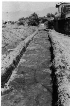
試掘トレンチ
