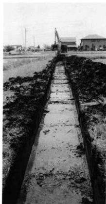
試掘トレンチ
