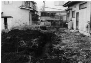
試掘トレンチ
