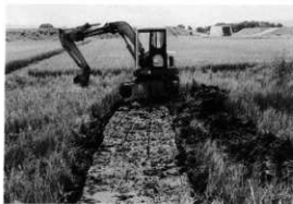
試掘トレンチ
