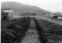
試掘トレンチ
