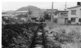
試掘トレンチ
