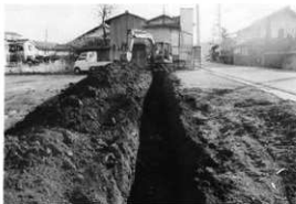
試掘トレンチ
