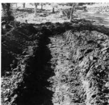
試掘トレンチ
