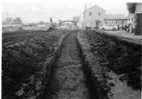
試掘トレンチ
