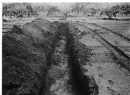
試掘トレンチ
