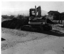
試掘トレンチ
