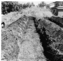
試掘トレンチ
