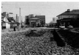
試掘トレンチ
