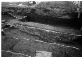
H31号住居址堀方全景(西から)
