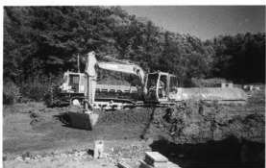
東地区表土除去作業（南西から）
