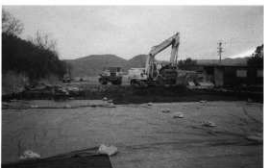
西地区表土除去作業（西から）
