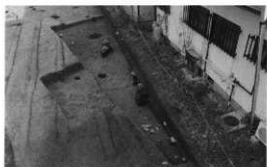
H3号住居址掘方全景 (西から)
