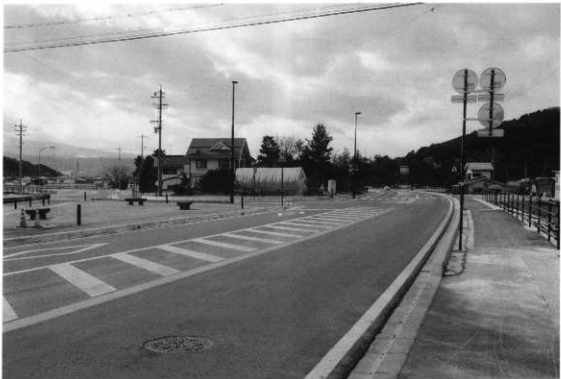
扇田遺跡工事後状況（東から）
