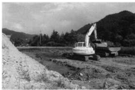
扇田遺跡平成16年度西側調査区表土除去作業（西から）
