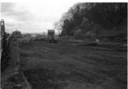
調査区埋め戻し作業（東から）
