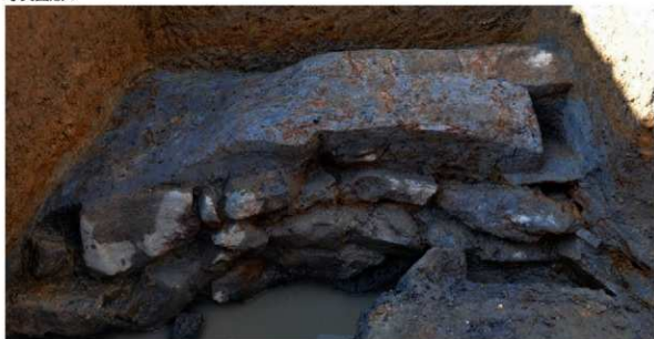
石積遺構 1528 西面天端の粘土被覆状況（東から）
