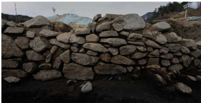
石積 A 西半東部における積石の状況
