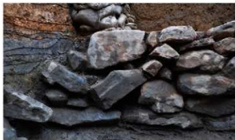
石積遺構 1528 西面
