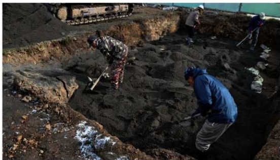
保護砂による埋め戻し
