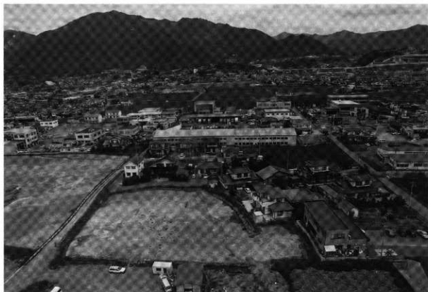
調査地区（南から）
