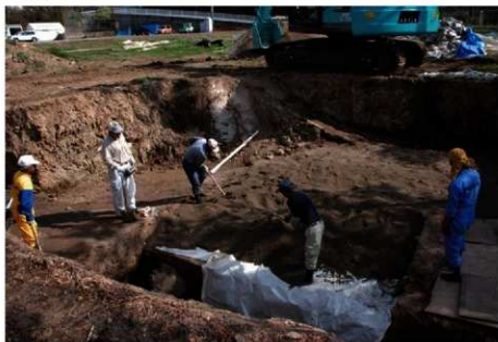
保護砂による埋め戻し
