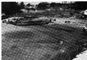
4 旧河川1号(南西方向より)
