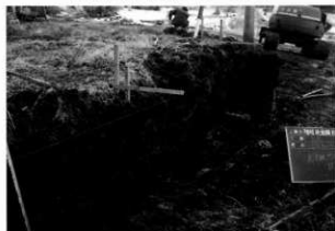
掘削・堆積状況
