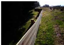
調査前に設置した上砂流出防止柵
