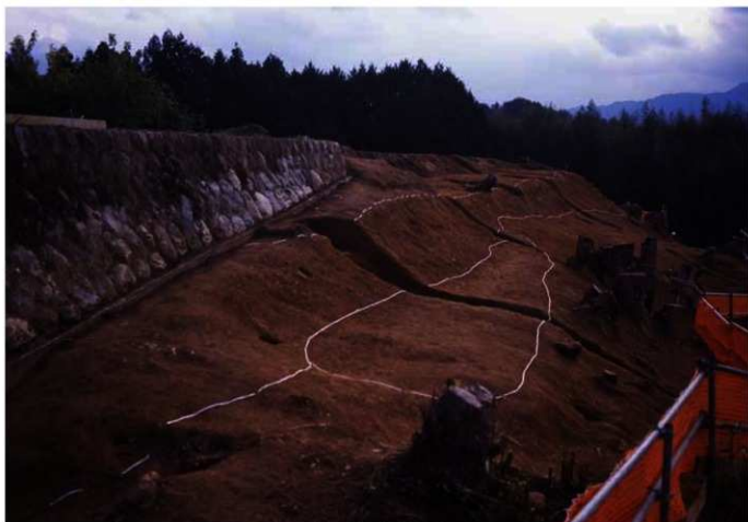
平場1・切岸1 全景（北より）
