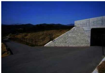
井戸端遺跡の現況
