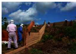
調査前に設置した土砂流出防止柵
