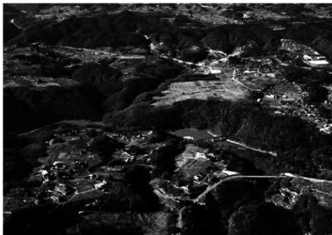
井戸端道跡、下村道跡（豊ヶ城跡）遠景（国土交通省中部地方整備局飯田国道事務所所提供）
