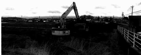
作業風景(表土掘削)一
