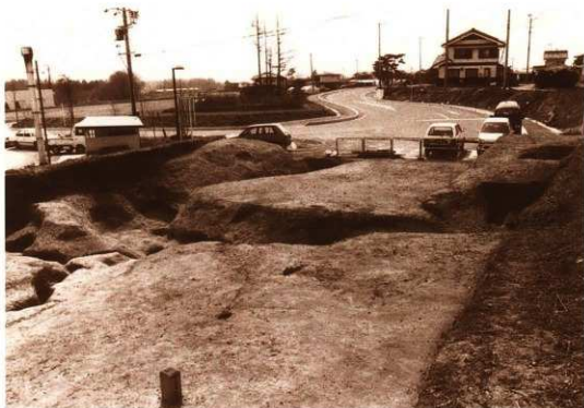
M3・M4 接続部分 (北東から)
