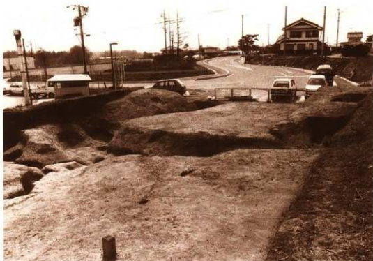
M3・M4 接続部分 (北東から)
