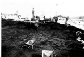
バックホーによる表土掘削
