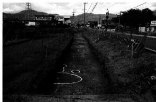
完掘状況 (南より)
