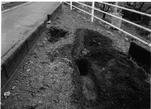
常光院塚 トレンチ掘削状況（北より）
