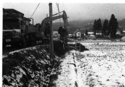
A 地点立会試掘状況（北より）
