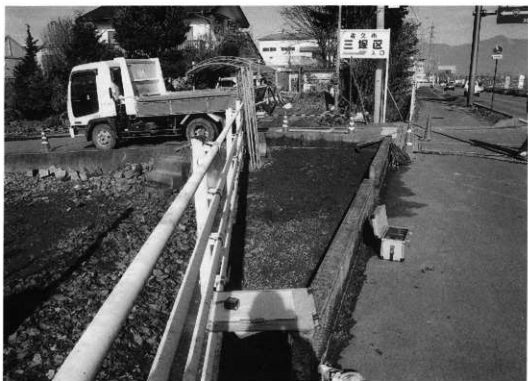
電光院塚 調査区埋め戻し状況（南より）
