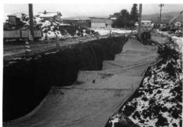
A 地点立会状況（北より）
