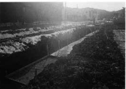
F 地点西側立会状況（東より）
