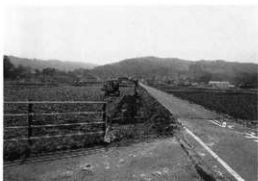
E 地点西側試験状況（東より）
