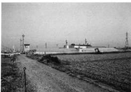
E 地点東側試験状況（南より）
