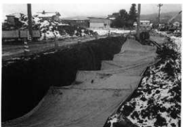
A 地点立会状況（北より）
