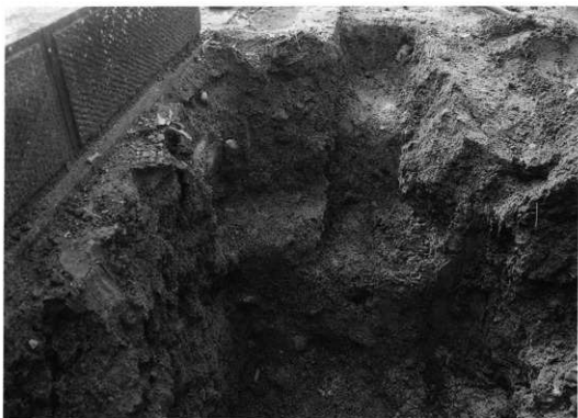
常光院塚 トレンチ掘削状況（北より）
