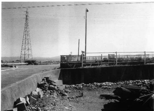
常光院堰 近景（西より）
