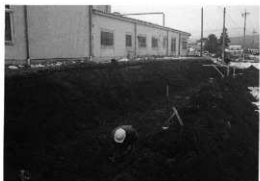
A 地点立会状況（北より）
