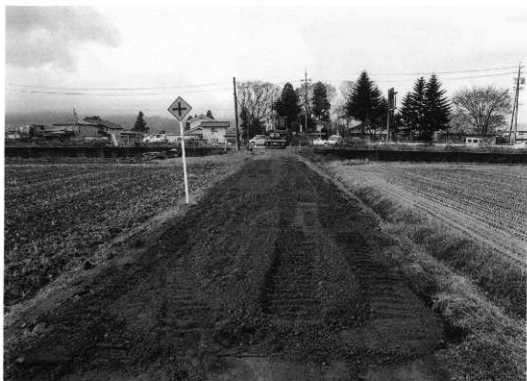
市道酒師IV 道路復旧状況（東より）
