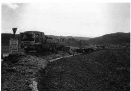
E 地点西側立会状況（東より）
