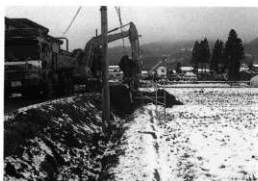
A 地点立会試掘状況（北より）
