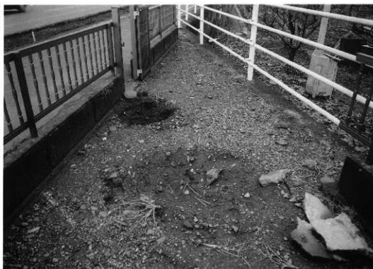
常光院塚 石碑と丸石の撤去状況 (北より)
