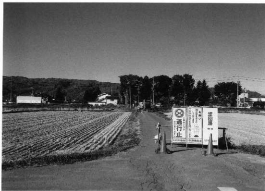
市道遺跡Ⅳ 掘削状況（東より）
