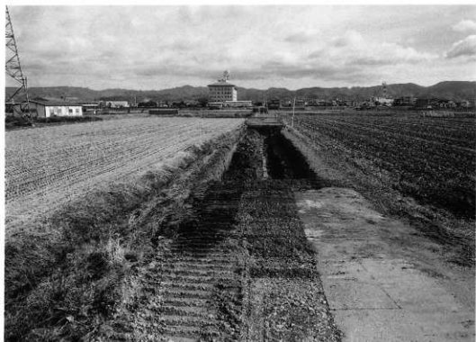
市道通跡Ⅳ 埋め戻し状況（西より、中央ガス埋設管）
