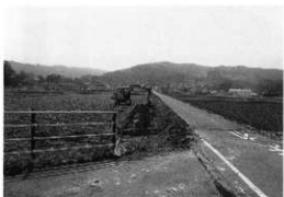
E 地点西側試験状況（東より）
