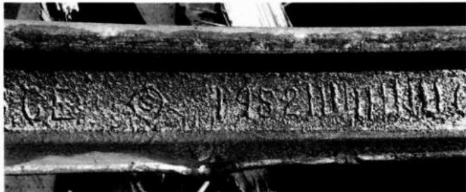
[写真 27] ホイストクレーンのレールの刻印「A.S.C.E. 1952」※該当箇所のコントラストを変えている
