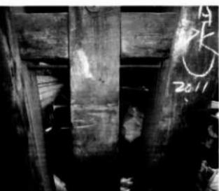
[写真 19] 斜材を接合するボルト
