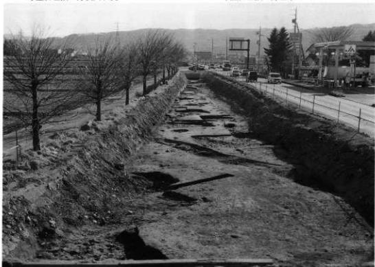
市道遺跡Ⅲ調査区全景（中央部から南部分を北より望む）
