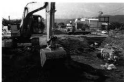
市道遺跡Ⅲ表土剥ぎ状況
