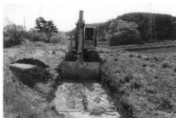
写真1 重機でトレンチを掘る
