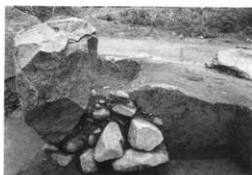
写真72 玄室東側壁裏込め石と盛土（南から）
