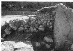
写真70 奥壁裏込めセクション（西から）
