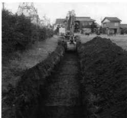
試掘トレンチ
