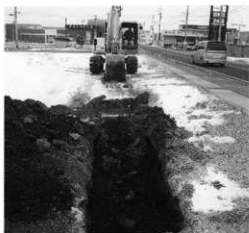
関金トレンチ
