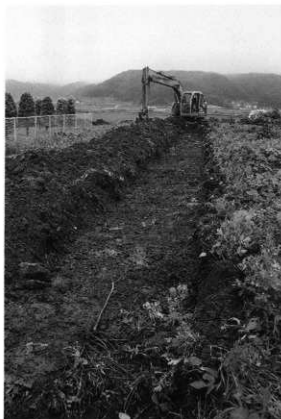
試掘トレンチ
