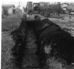
試掘トレンチ
