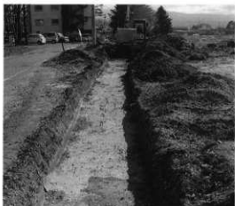
試掘トレンチ
