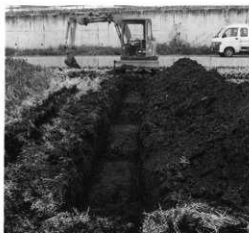
試掘トレンチ
