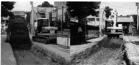
調査第Ⅰ区 土砂埋め戻し状況（運搬）
