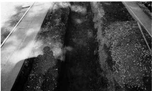
調査第⑦東区 遺構確認状況（西より）
