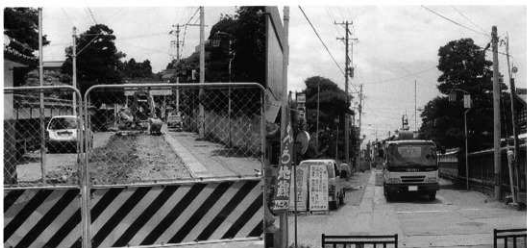
調査第Ⅰ区 表土除去作業
