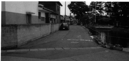
調査第⑤区 調査前全景（東より）
