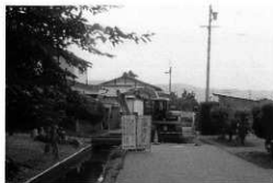
調査第①西区 掘め戻し状況 (東より)
