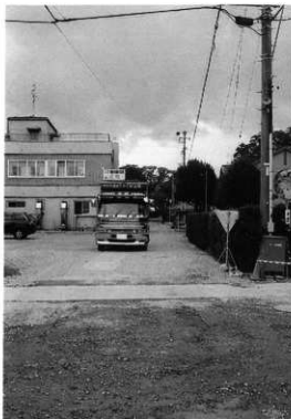
調査第③区 土砂埋め戻し状況（東より）
