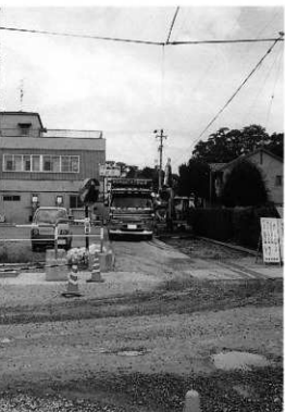
調査第③区 表土除去・土砂運搬状況
