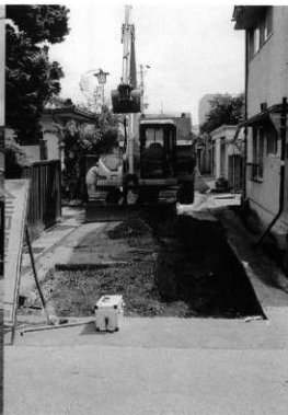
調査第⑤区 表土掘削状況（西より）
