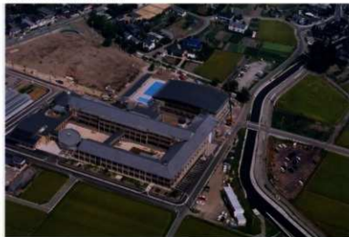
完成が近い新校舎
