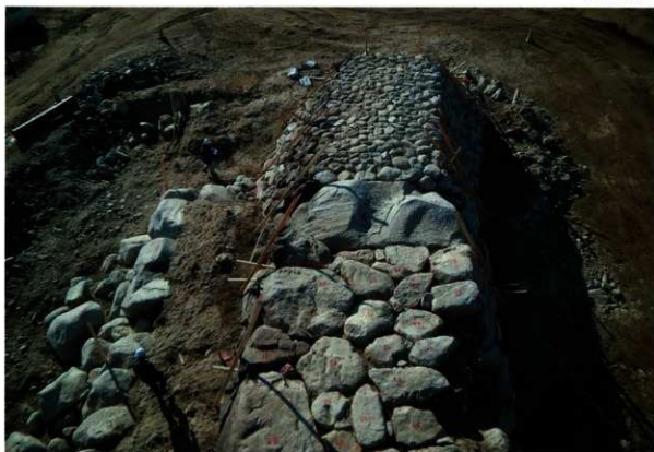
(1) C堤防下流部 増築部の馬踏
