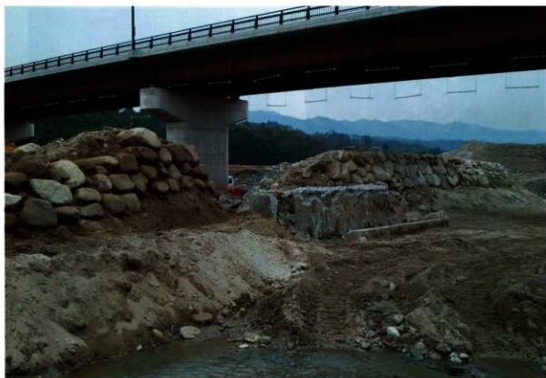
(2) C堤防川裏側（北西→）
