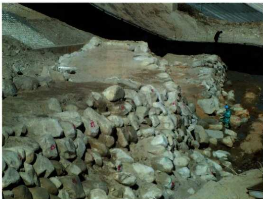
(2) A・B・D堤防 馬踏 (南→)
