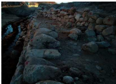
(3) A堤防馬踏とB堤防川 表側石積み (北→)
