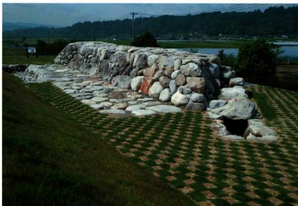
(2) C堤防下流部 増築部の移築（灌漑水路より南側、東→）
