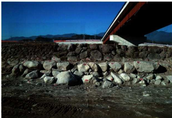
(1) C堤防川表側（下流・先端部、東→）
