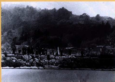
明治40年ころの理兵衛堤防（下流側）
