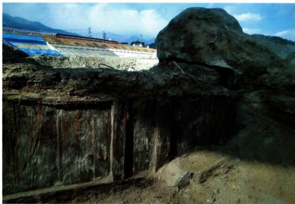
(2) 灌溉用水路 堤体内部の木樋細部
