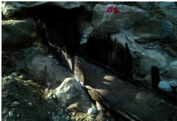
(1) 灌溉用水路 入口木樋細部
