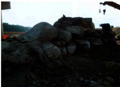
(1) 堤体内部の灌漑用水路の石組 (南→)
