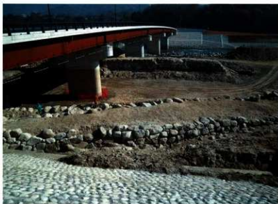
(2) B堤防 川裏側石積みと馬踏 (北西→)
