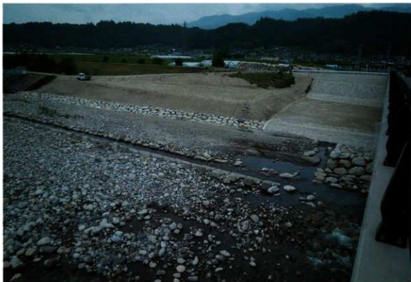
(1) 理兵衛堤防遠景 (工事完了、東→)
