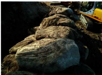
(2) 堤体内部の灌漑用水路の石組
