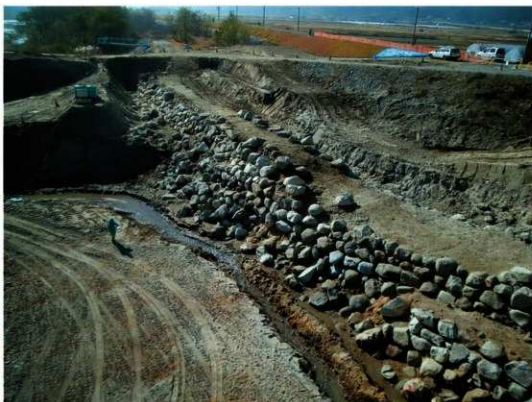
(1) A・B・D堤防 川表側石積みと馬踏 (北東→)
