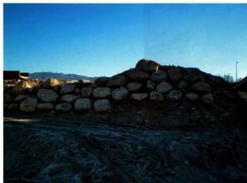
(3) C堤防中間部 川裏側石積み (西→)
