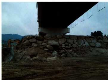
(4) C堤防 川裏側石積み 灌漑用水路出口付近 (西→)
