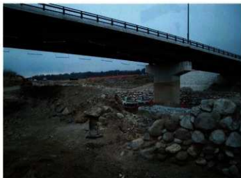
(1) C堤防中間部 川表側石積み (北東→)
