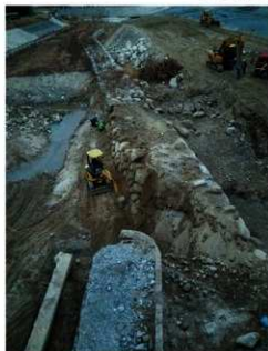
(2) C堤防中間部と上流側 (南→)
