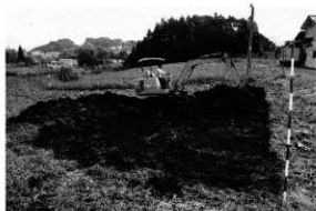
2. 表土除去 (北から)
